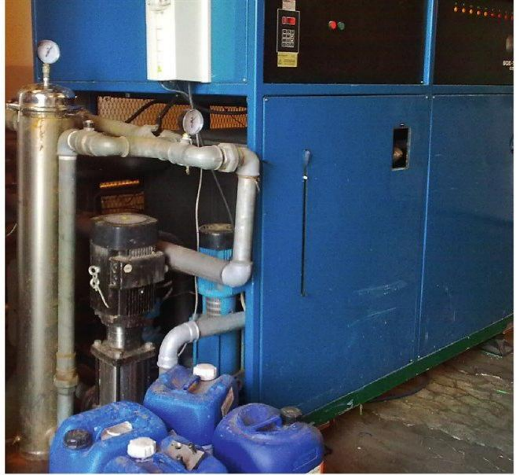
Buffertanken til kølevand hos Ulstrup Plast A/S, der er forsynet med en Grander enhed.
